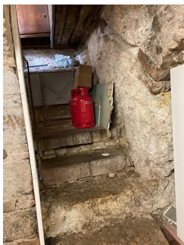
Escalier de la porte d'entrée
